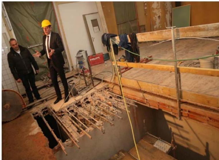
À Vesoul, par exemple, les travaux de mise en accessibilité de l'hôtel de ville seront subventionnés par l'État à hauteur de 169 000 €. Photo d'archives Dominique ROQUELET
